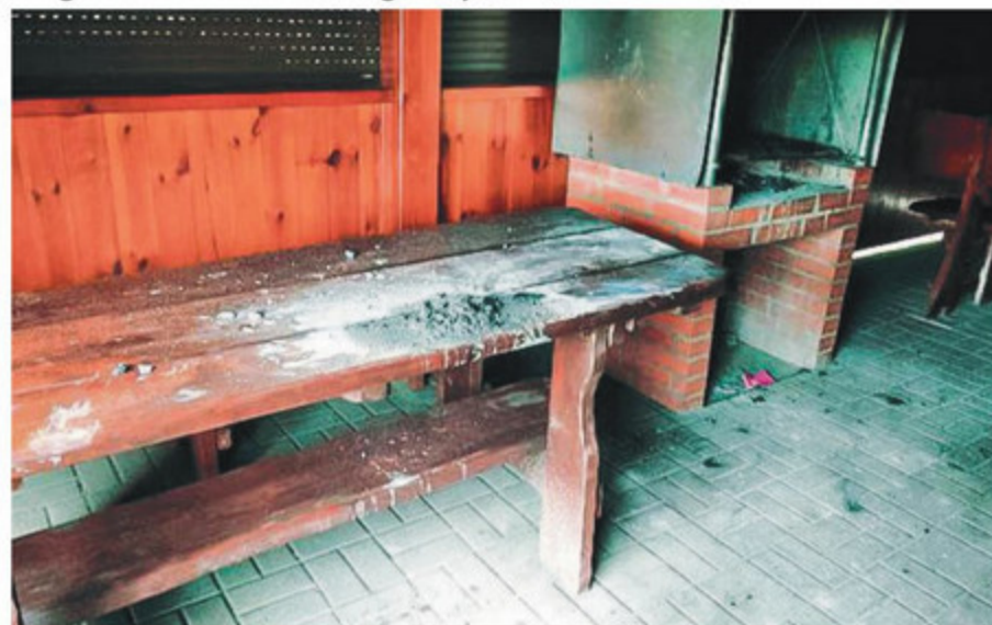
W sołectwie Pniówek zdewastowano wiatę.
