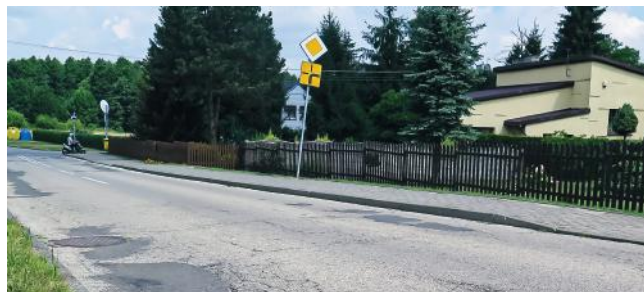
Naprawa nawierzchni obejmie m.in. ulicę Mickiewicza...
