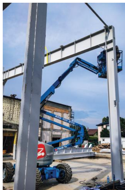
Montaż konstrukcji stalowej sali gimnastycznej w Krzyżowicach.
